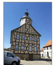
Saniertes ehemaliges Rathaus Großenehrich
