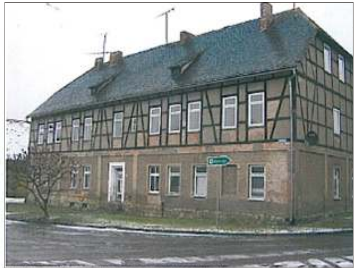
Südliche Ansicht aus Richtung Klosterhof
