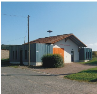
Hier entsteht der Tourismusstützpunkt
