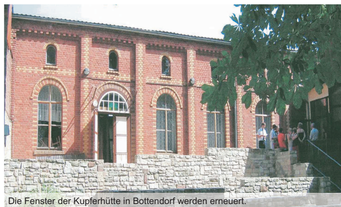
Die Fenster der Kupferhütte in Bottendorf werden erneuert.
