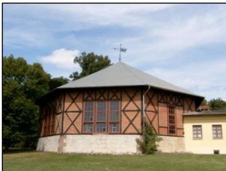
Die historische Reithalle erhielt ein neues Dach
