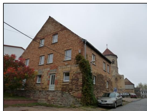
Hier entsteht ein moderner Empfangs- und Servicebereich für die Besucher der Klosterruine St. Wigbert in Göllingen Quelle: LEADER-Management
