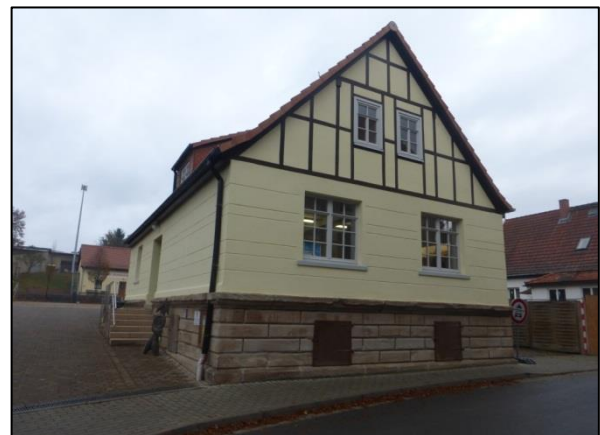
Museum in Steinhaleben mit neuer Fassade
