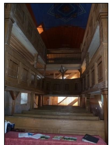
erneuerte Empore mit Treppe und Gaubenverschalung
