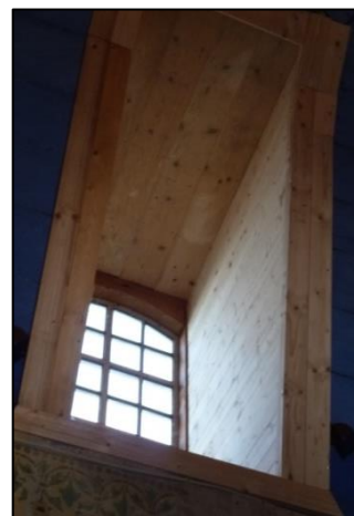
erneuerte Empore mit Treppe und Gaubenverschalung
