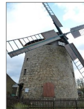
Vereins- und Feuerwehrheim in Rockensußra und Turmwindmühle „Erna“ in Immenrode
