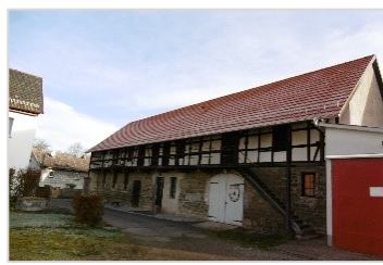
saniertes Dach Rockensußra
