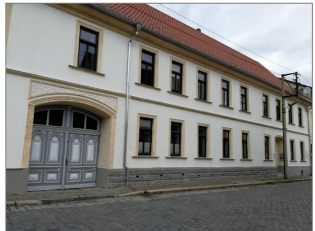
Greußen: Saniertes Pfarrhaus
